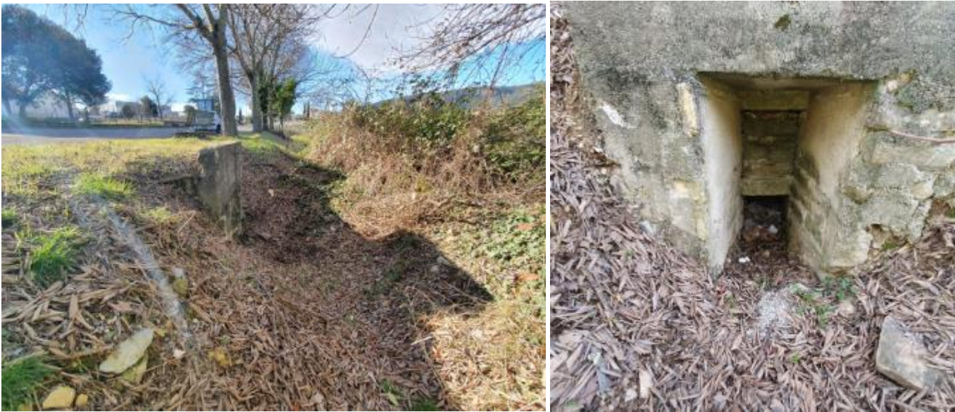
Figure 3 : Photographies - Exutoire du sous bassin versant Sud
