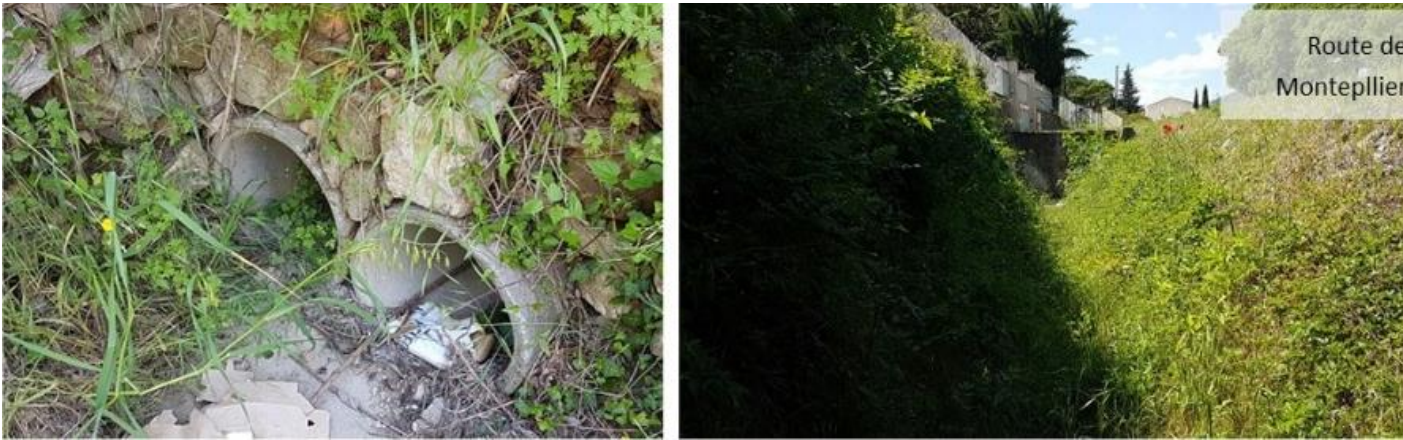
Figure 4 : Photographies de l’exutoire après la traversée sous la route de Montpellier
